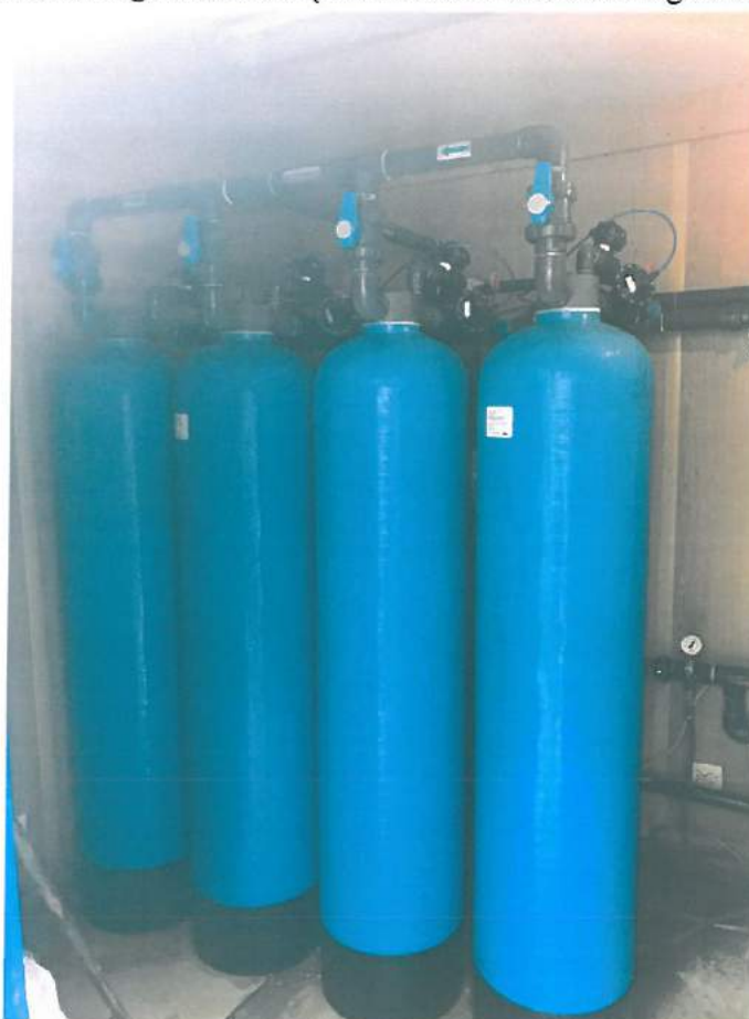
43 pav. Spenglos kaimo vandenvietės vandens gerinimo įrenginių rekonstrukcija
